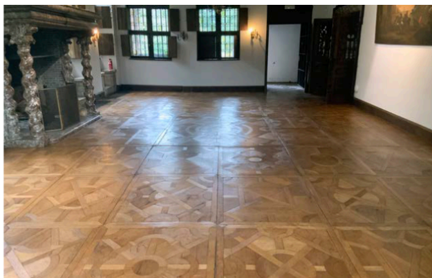
Nach dem Abschluss der Arbeiten erstrahlt der Parkettboden im großen Saal in neuem Glanz.
